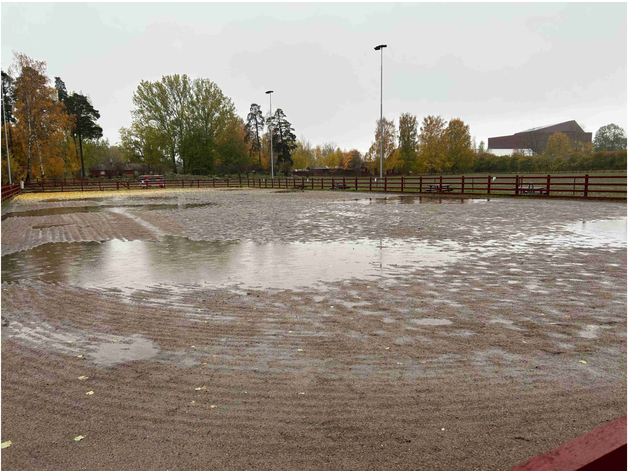
Bild 9: Exempel på ridbanans skick efter kraftigt regn i oktober. Svackor i ridbanan syns tydligt i form av vattenansamlingar. Notera även mattan av löv i borte ändan - de bör ge ett önskat tillskott av organsikt material till ridbanan (om inte löven blåster bort).
